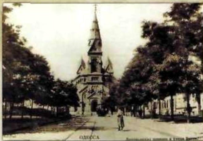
Второе здание кирхи (1897)
