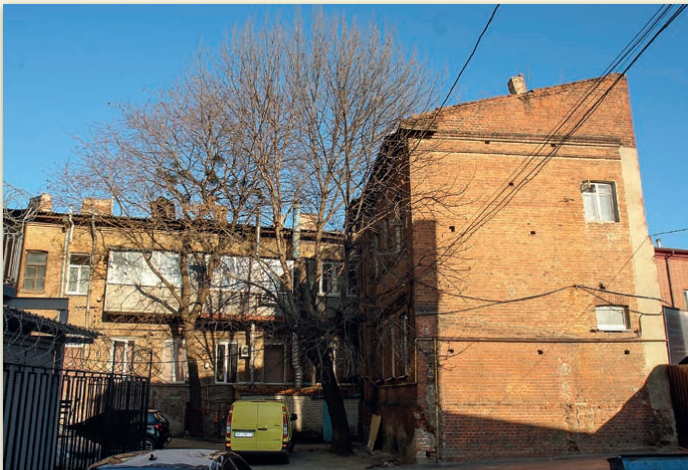
Дом Дмитрия фон Циглера вид со двора, фото А. Парамонова, 2020 год Das Haus von Dmitrij von Ziegler, Ansicht vom Hof. Foto: A. Paramonow, 2020
