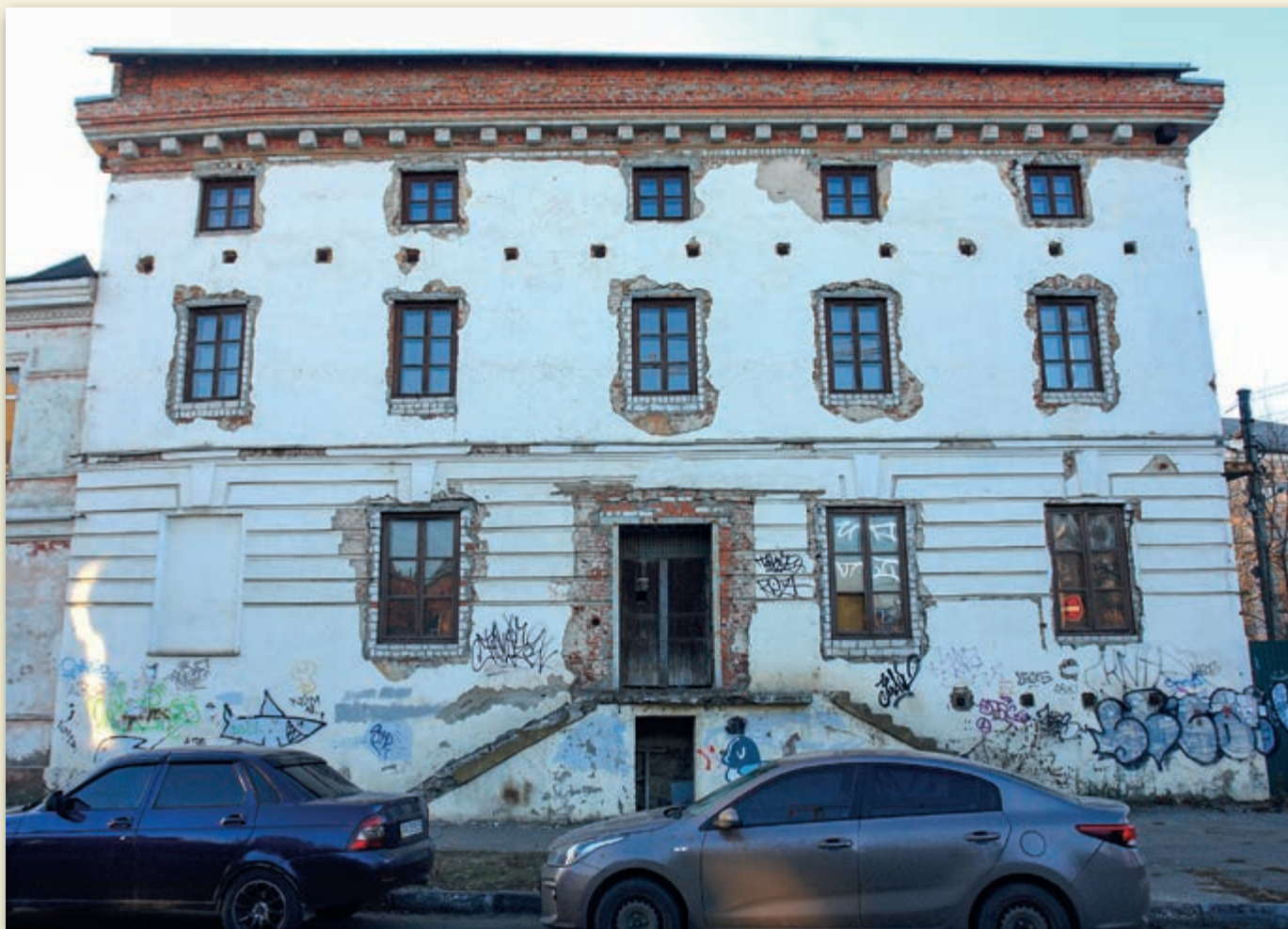
Почтово-телеграфная контора со стороны Шляпного переуллка, фото А. Парамонова, 2020 год Das Post- und Telegraphenamt, Ansicht von der Seite der Schlapnyj-Gasse. Foto: A Paramonow, 2020
