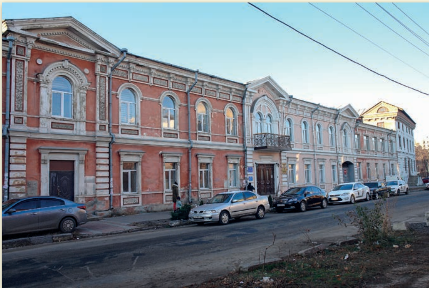
Почтово-телеграфная контора со стороны Шляпного переуллка, фото А. Парамонова, 2020 год Das Post- und Telegraphenamt, Ansicht von der Seite der Schlapnyj-Gasse. Foto: A Paramonow, 2020
