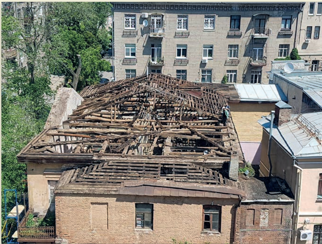
Работы по перестройке дом пастора по улице Гоголя № 2, фото В. Горбоносова, 2020 год Umbauarbeiten am Pfarrhaus in der Gogol-Straße, 2. Foto: W. Gorbonosow, 2020
