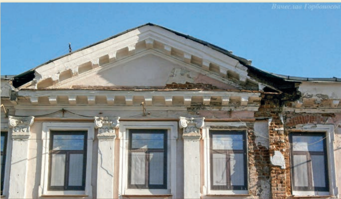
Усадебный дом Поповых по ул. Кооперативная 24, деталь фасада, фото В. Горбоносова, 2019 год Das Herrenhaus der Familie Popow in der Kooperatiwnaja-Straße, 24, ein Fassadenelement. Foto: A. Paramonow, 2016
